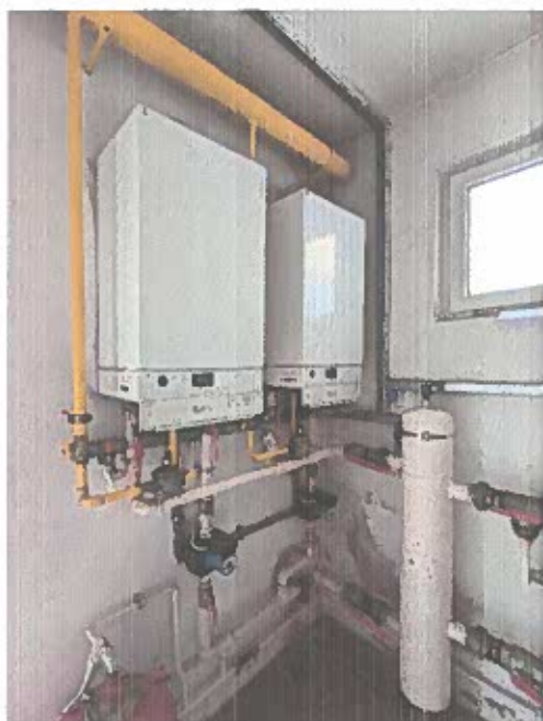
Poza 6. Poză din centrala termică, se observă cele două cazane care asigura încălzirea și boilerul pentru stocarea apei calde de consum
